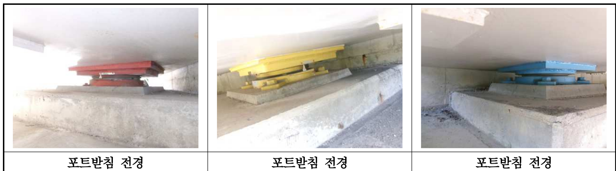
【사진 13.3.10】 교량받침 전경
