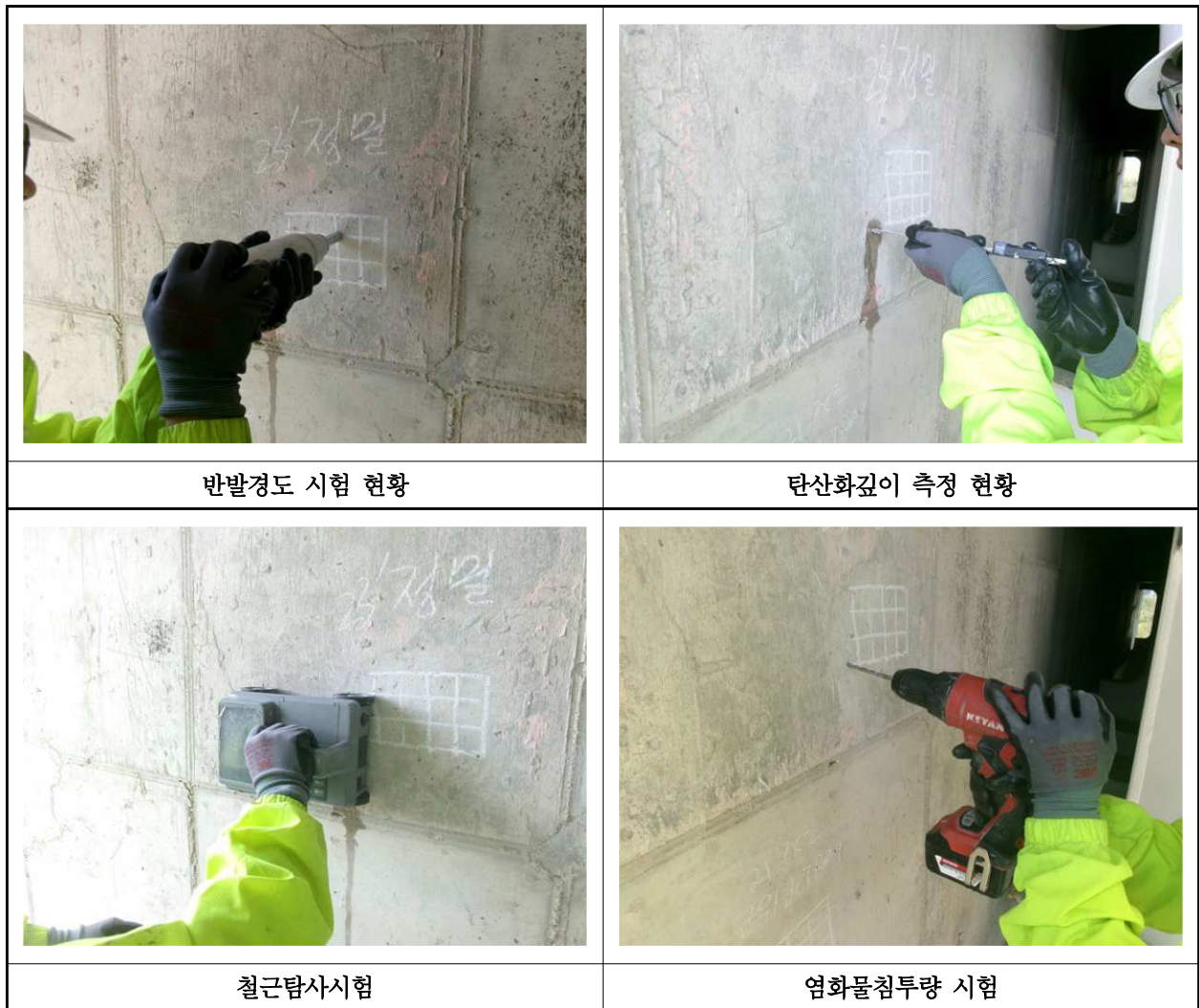
【사진 13.4.1】 콘크리트 내구성조사 현황
