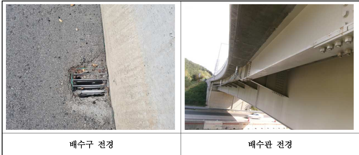
【사진 13.3.19】 배수시설 전경
