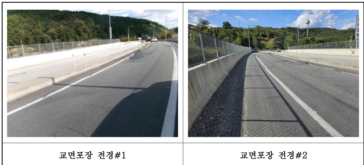
【사진 13.3.17】 교면포장 전경
