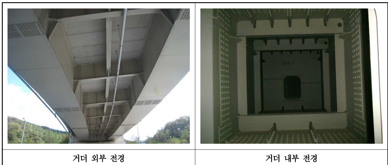
【사진 13.3.4】 거더 전경
