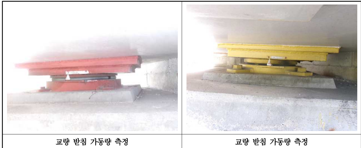
【사진 13.3.13】 교량받침 이동량 측정
