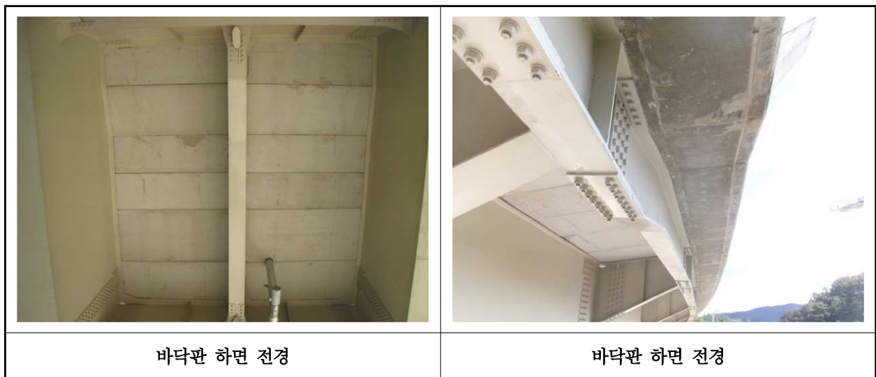
【사진 13.3.2】 바닥판하면 전경
