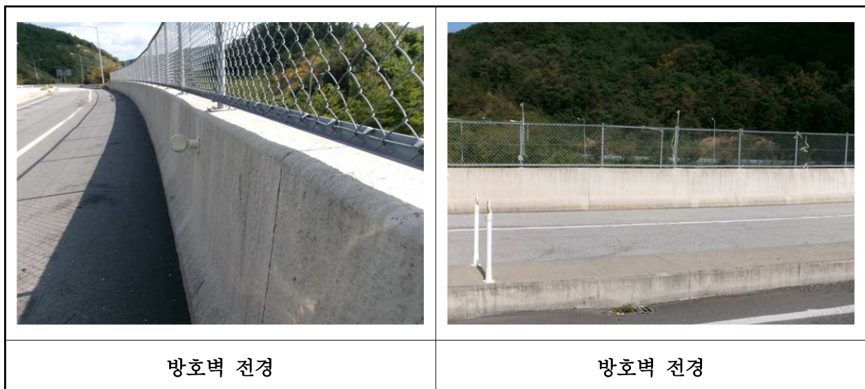
【사진 13.3.21】 방호벽 및 중앙분리대 전경
